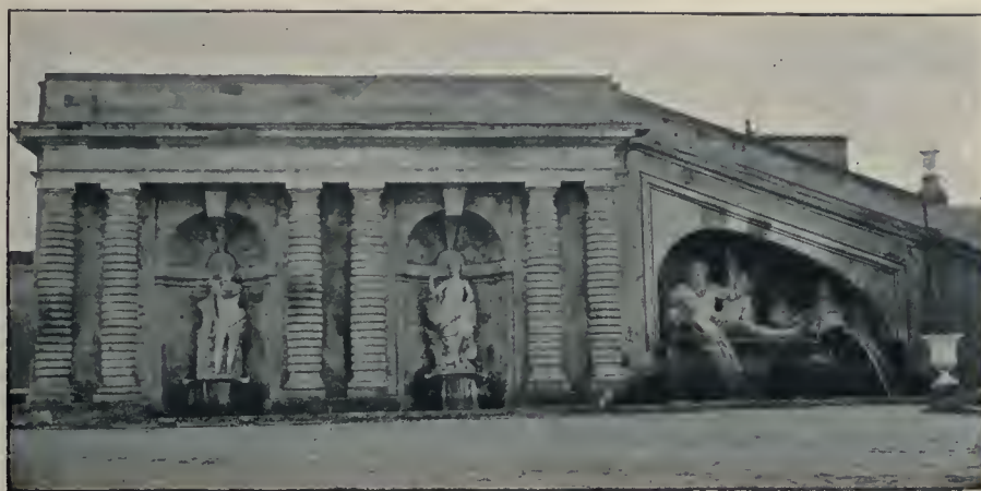
CHANTILLY, côté gauche du grand Degré (exécuté par Jean HARDY, d'après les dessins de Le Nôtre).
